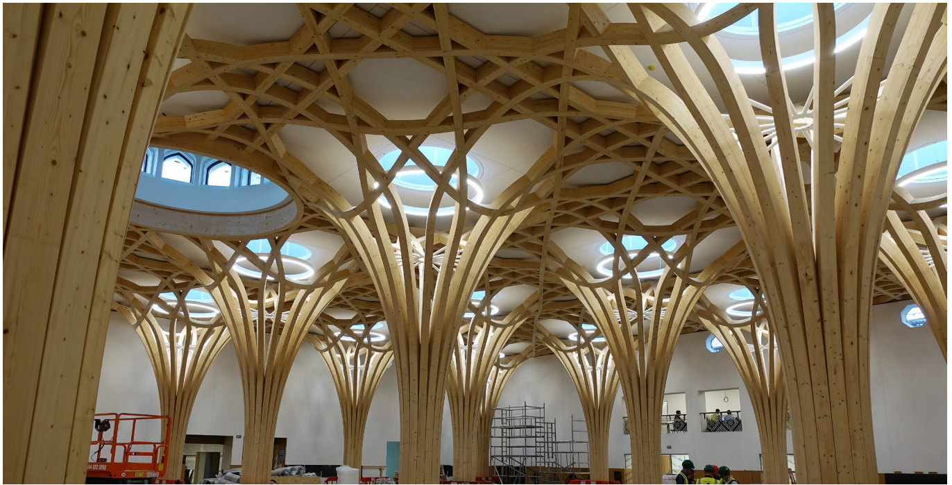
Dreissig frei geformte Holzsäulen tragen das Flechtwerk der Cambridge-Moschee. Realisiert wurde das Projekt 2018 von der Blumer-Lehmann AG aus Gossau (SG).
